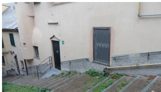
Figura 1.1 - Vista della facciata esposta a Est
