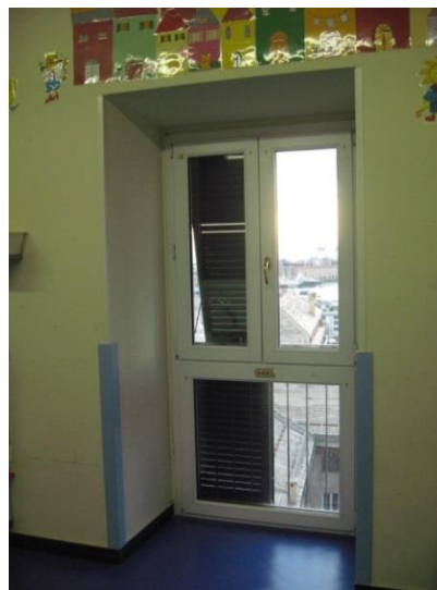
Figura 4.4 - Particolare di un infisso dell'asilo nido.
