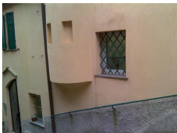
Figura 4.5 – Rilievo termografico dei serramenti esterni verso est
